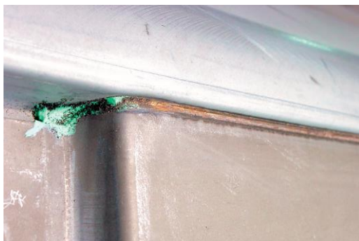
Figura 83 – Soldadura láser bajo techo. Fuente: CESVIMAP
